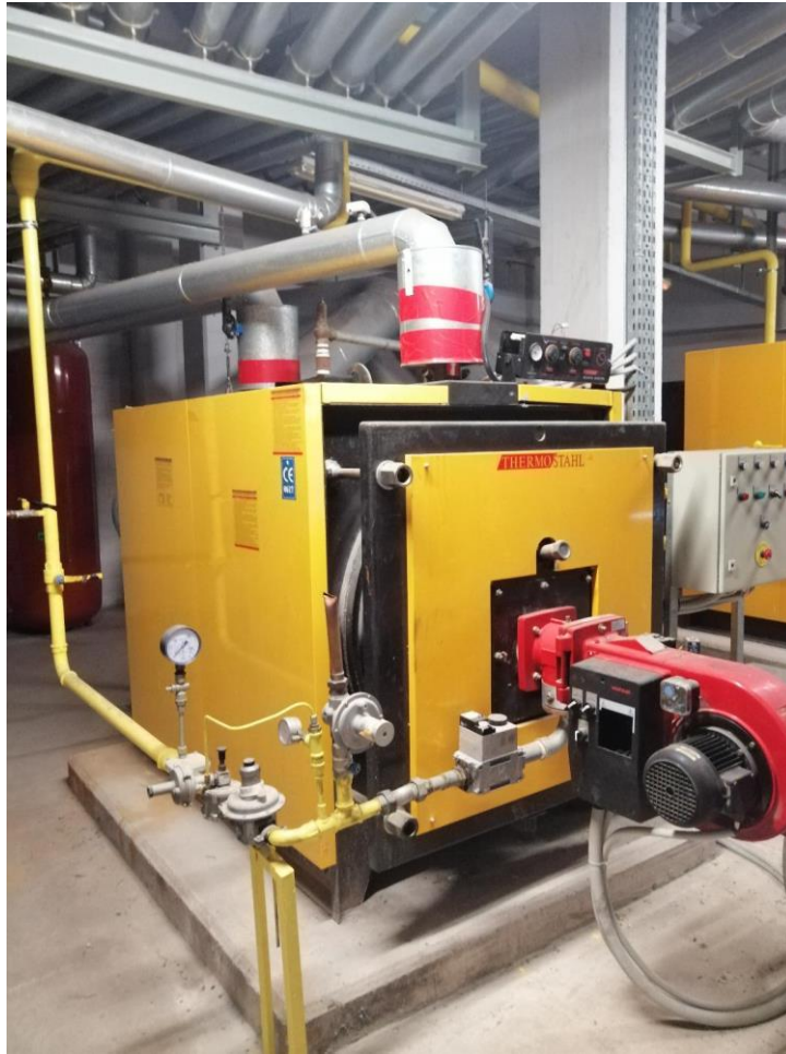
Εικόνα 6: Λέβητας EN 400 της THERMOSTAHL και καυστήρας GL7/1-DWeishaupt
