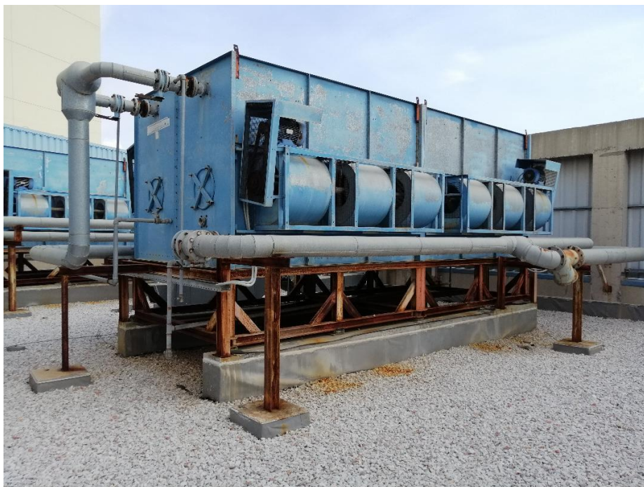
Εικόνα 4: Πύργος Ψύξης ΠΑΚ – 144D απόδοσης 600 Ψ. Τ., της AIRTECHNIC
